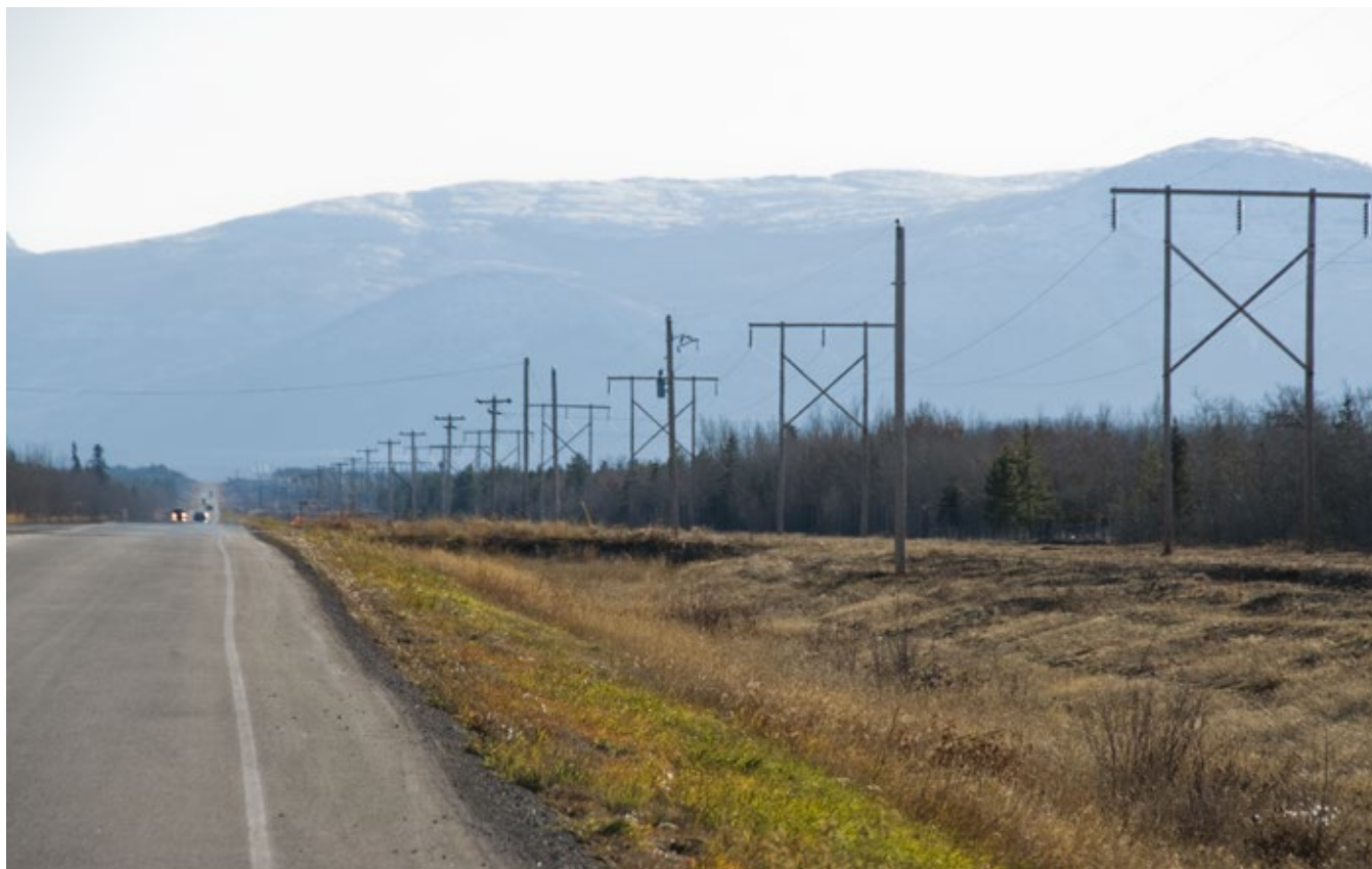
Lignes électriques le long de la route.
