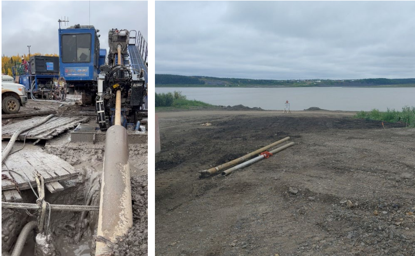
Forage directionnel horizontal sous le fleuve Mackenzie. À droite, le point de sortie de forage sur la rive nord.
