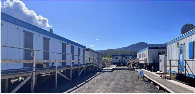
Le camp 208, au Yukon, a accueilli 50 membres du personnel de ROHL pendant les travaux. Le camp est fermé pour 2023 et ne rouvrira pas pour la reprise des travaux en 2024.
