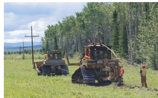
La méthode d'enfouissement conventionnel, pour les zones où les conditions du sol sont stables, fait généralement appel à deux bouteurs câblés ensemble.
